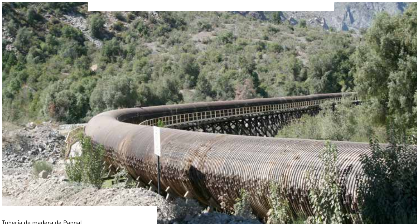
Tubería de madera de Pangal. Autor: Christian Matzner, CMN – MH
